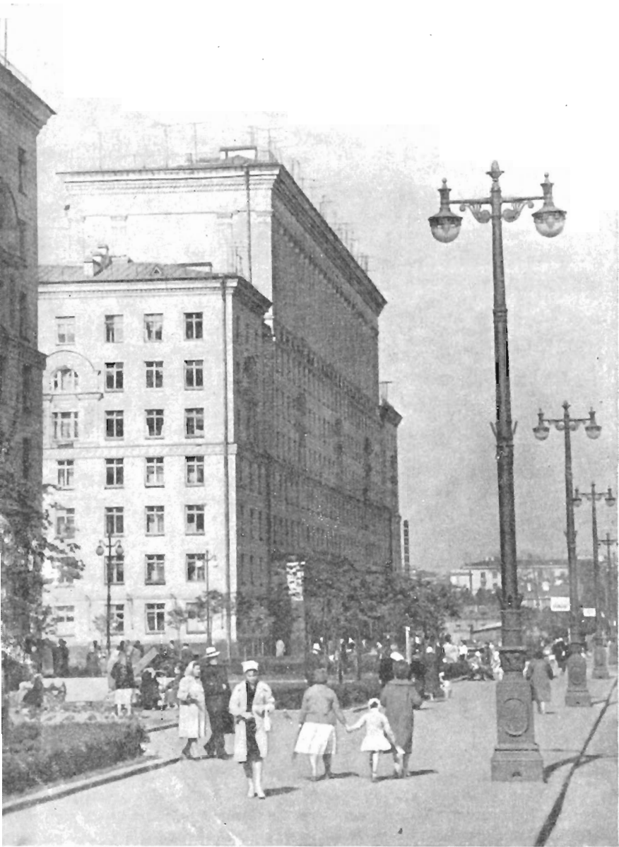
Жилые дома в южной части Московского проспекта.
