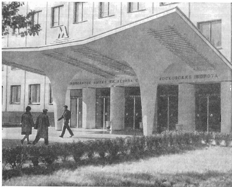
Наземный вестибюль станции метро „Московские ворота“.
