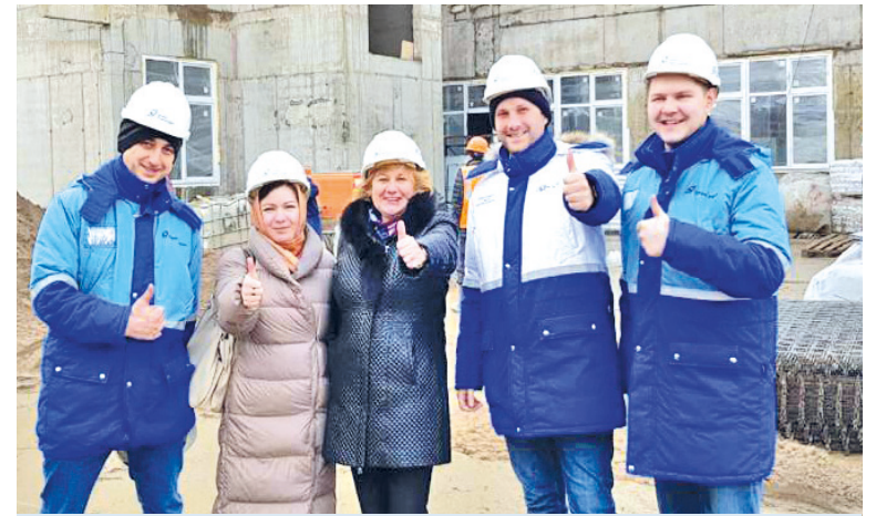
Елена Полякова (по центру) на площадке будущей школы в апреле 2019 года
