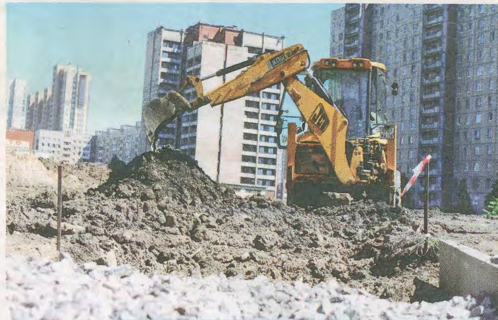
На Звёздной, 5, вовсю работает строительная техника. Муниципалы обещают, что к осени этот двор полностью преобразится
