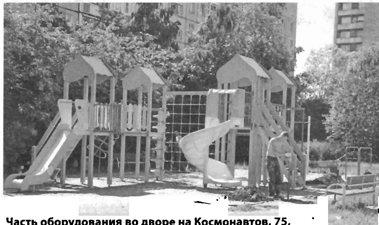
Часть оборудования во дворе на Космонавтов, 75, уже установлена, но основные работы ещё впереди
