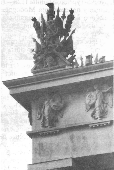
Арматура. Композиция на аттике ворот.
