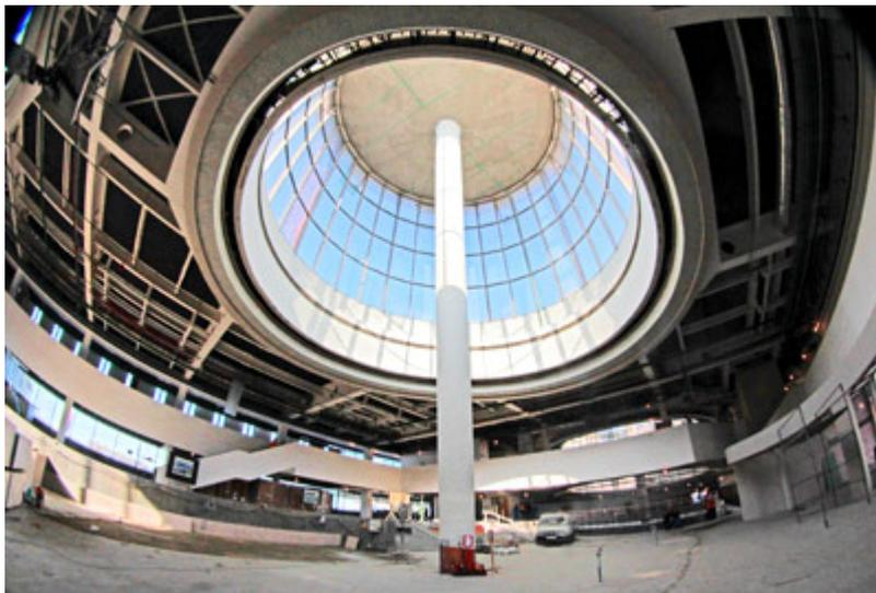
Сейчас все здесь ободрано до бетона. Рабочие, как видно, только приступили к устройству новых интерьеров: начали укладывать напольную плитку. Дизайн помещений будет напоминать новый терминал. В частности, в том же стиле обещают выполнить потолок.
