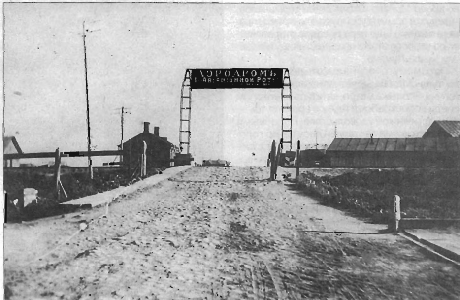
Въезд на Корпусной аэродром, фото 1913 г.
