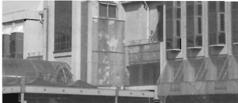
Гостиница «Северная корона» на Карповке. Строительство с 1986. Архитекторы А.И. Прибульский, Л.А. Ухова, М.А. Рейнберг, А.Г. Мудролюбоб. Фрагмент
