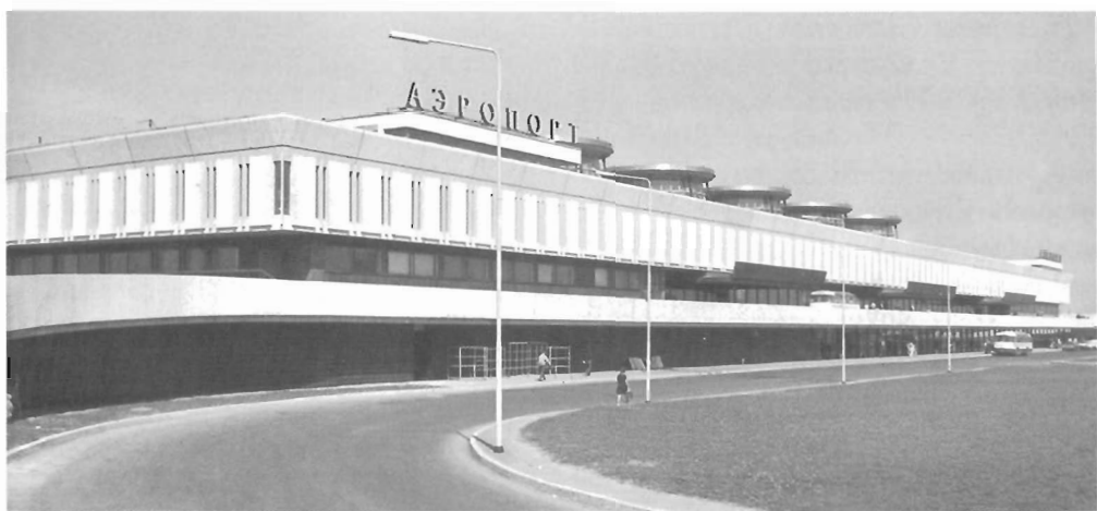
Аэровокзал «Пулково». 1972–1975. Архитекторы А. В. Жук, Ж. М. Вержбицкий, Г. М. Вланин, инженеры Н. В. Максимов, С. М. Кузьменко
