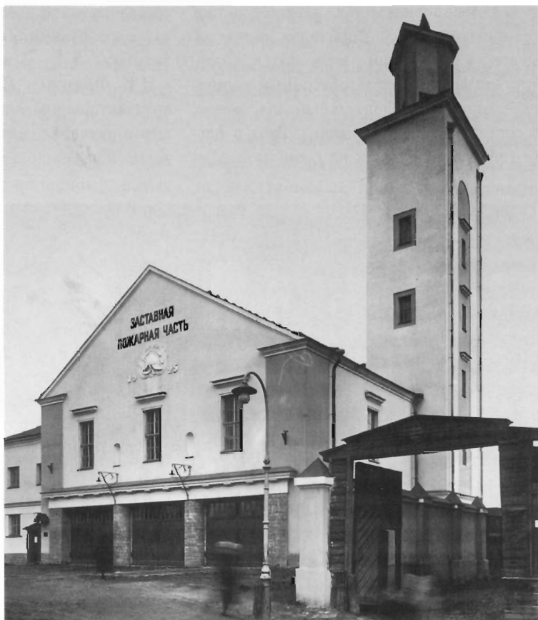
Здание пожарной части у Московских ворот. 1925-1926.
