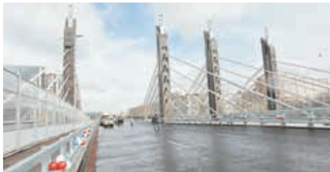
Строительство развязки завершается в соответствии с графиком. Срок окончания работ по контракту – 30 июня 2017 г. ФОТО: GOV.SPB.RU
