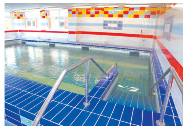
Выполнен капитальный ремонт бассейна в детской поликлинике № 39
