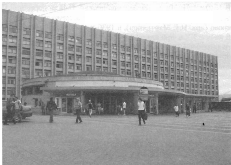
Наземный вестибюль станции «Электросила» и корпус одноименного предприятия
