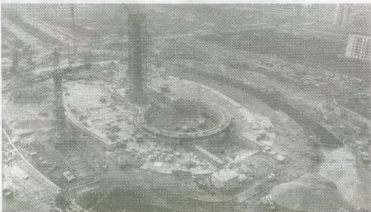
Идёт строительство памятника
