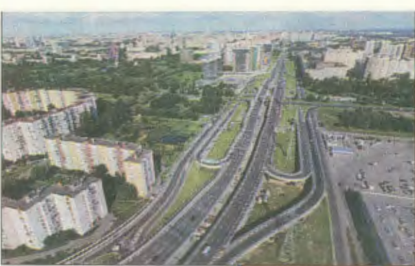
Путепроводная развязка на пересечении Пулковского ш. с Дунайским пр.
