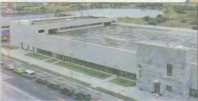
Внуковская ул., д.6, стр.1, паркинг
