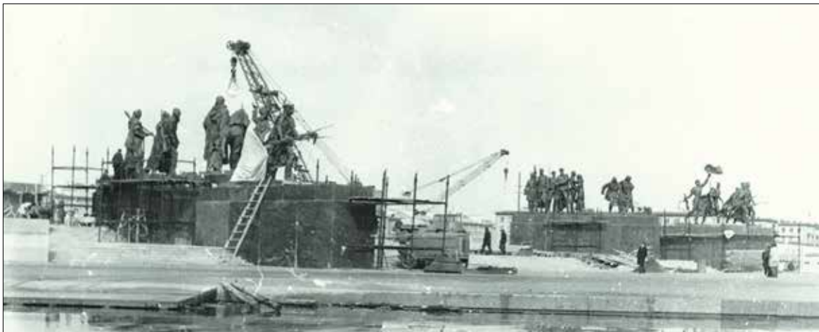
Установка Монумента героическим защитникам Ленинграда, 1975 год
