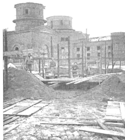
Вид на Главное здание в период восстановления
