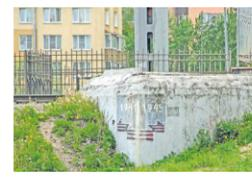
Одноамбразурный пулемётный полукапонир (ПДОТ-1) № 29. Построен в 1943 г. Директриса амбразуры: 122°. Был вооружён, вероятно, казематной шаровой 7,62-мм пулемётной установкой НПС-3. Обеспечен от одного попадания 155-мм немецкой гаубицы. При расширении железной дороги ДОТ был разрезан пополам. Сохранилась восточная часть.
