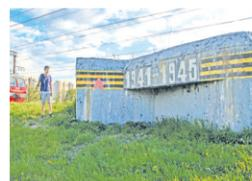
Одноамбразурный артиллерийский полукапонир (АПК) № 42 оборонительного рубежа «Ижора». Построен в 1943 г. Амбразура под казематную шаровую 76,2-мм артиллерийскую установку А-17. Обеспечен от одного попадания 155-мм немецкой гаубицы. Директриса амбразуры: 108°. Имеется защитная стенка типа орильона.
