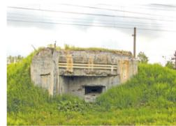
Одноамбразурный пулемётный полукапонир (ППК-1) № 24. Амбразура под казематную шаровую 7,62-мм пулемётную установку НПС-3. Обеспечен от одного попадания 155-мм немецкой гаубицы. Оборонительный рубеж «Ижора» (1943 г.). Директриса амбразуры: 90°. Имеется защитная стенка амбразуры типа орильона.
