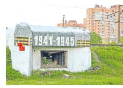
Одноамбразурный артиллерийский полукапонир (АПК) № 27. Построен в 1943 г. Амбразура под казематную шаровую 76,2-мм артиллерийскую установку А-17. Обеспечен от одного попадания 155-мм немецкой гаубицы. Директриса амбразуры: 75°. Имеется защитная стенка амбразуры типа орильона.
