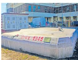
Двухамбразурный пулемётный ДОТ (ПДОТ-2) № 75 фронтального и косопримельного огня. Построен в 1943 г. по довоенному типовому проекту № 117 (второй вариант), по которому строились сооружения в 1940–1941 гг. Директрисы амбразур: 180° и 235°. Был вооружён казематными шаровыми 7,62-мм пулемётными установками НПС-3. Обеспечен от одного попадания 155-мм немецкой гаубицы.
